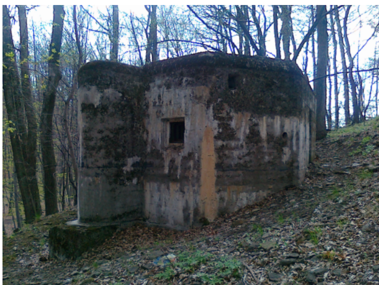
Obr.7 Pozostatky guľometného bunkra
